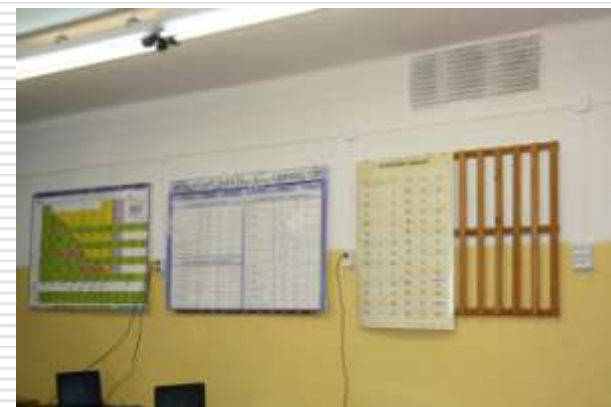
Установка дополнительных розеток для ноутбуков
