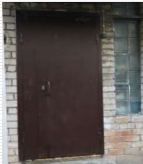
Замена дверного блока в столовой
